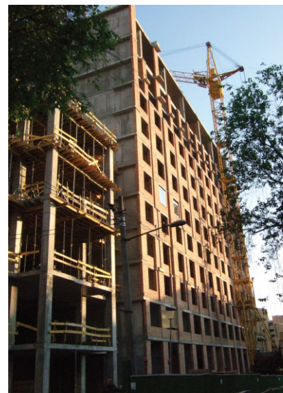
8 Jahre nach Baubeginn ...
